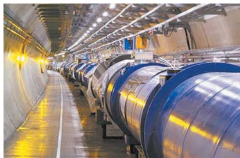
Рис. 119. Участок кольца коллайдера в тоннеле
