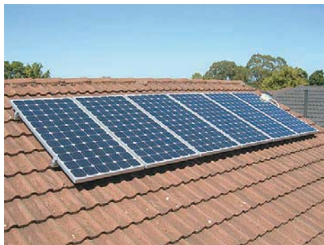
Рис. 27. Солнечная батарея, изготовленная с применением кристаллического кремния
